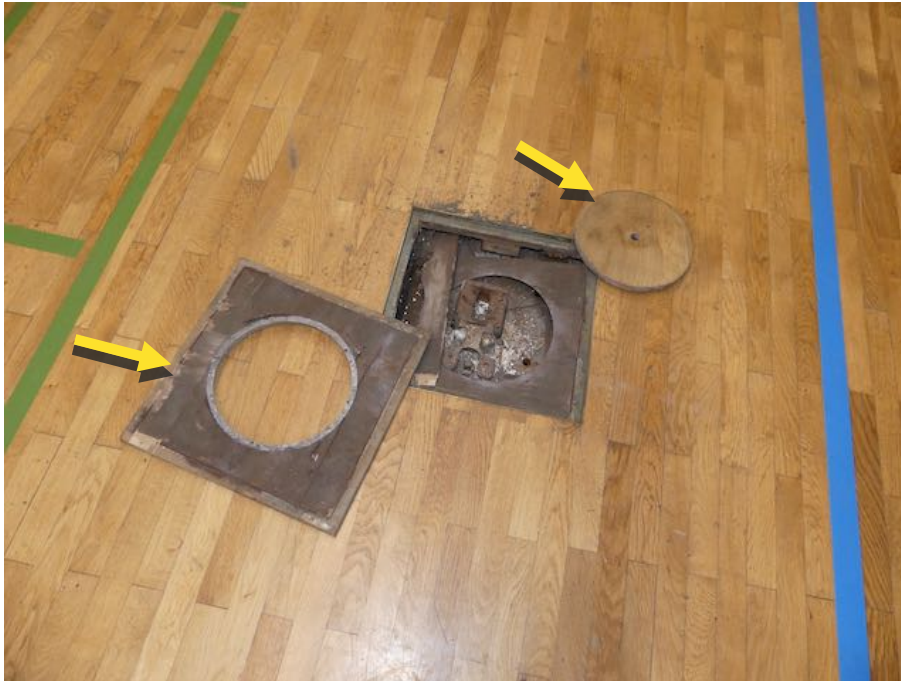
Foto 7: Turnhalle hinterer Teil Mitte, exemplarische Aufnahme, Übersicht Entnahmestelle Probe 80766, sichtbarer Bewuchs der Holzunterseiten
