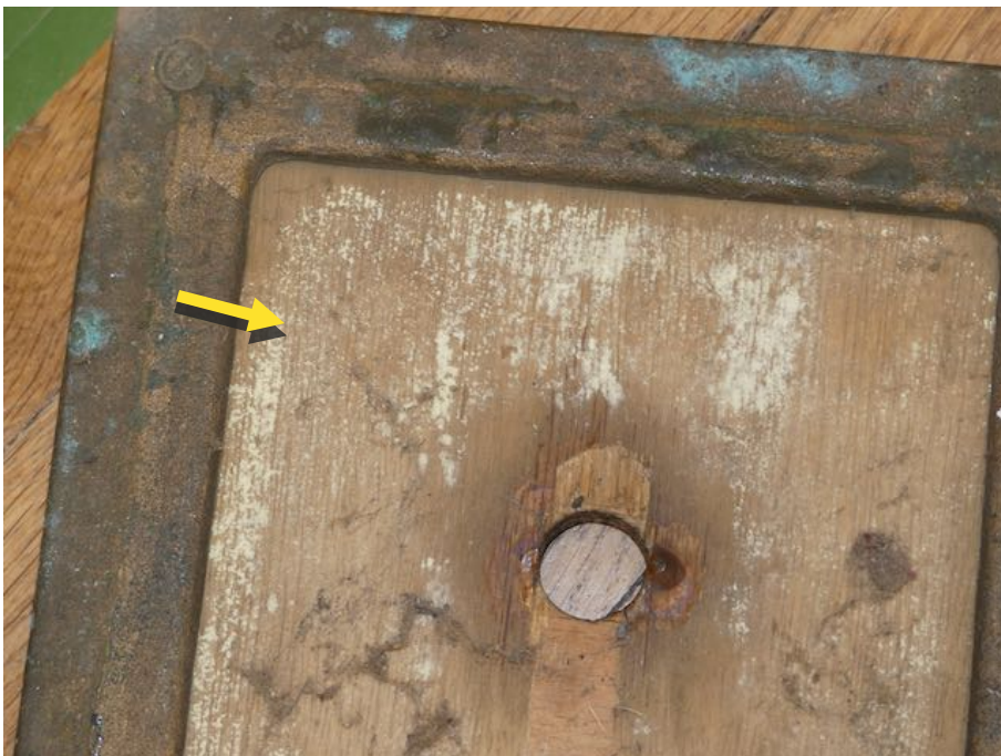
Foto 10: Turnhalle hinterer Teil Mitte, exemplarische Aufnahme Entnahmestelle Probe 80767, sichtbarer Bewuchs der Holzunterseiten
