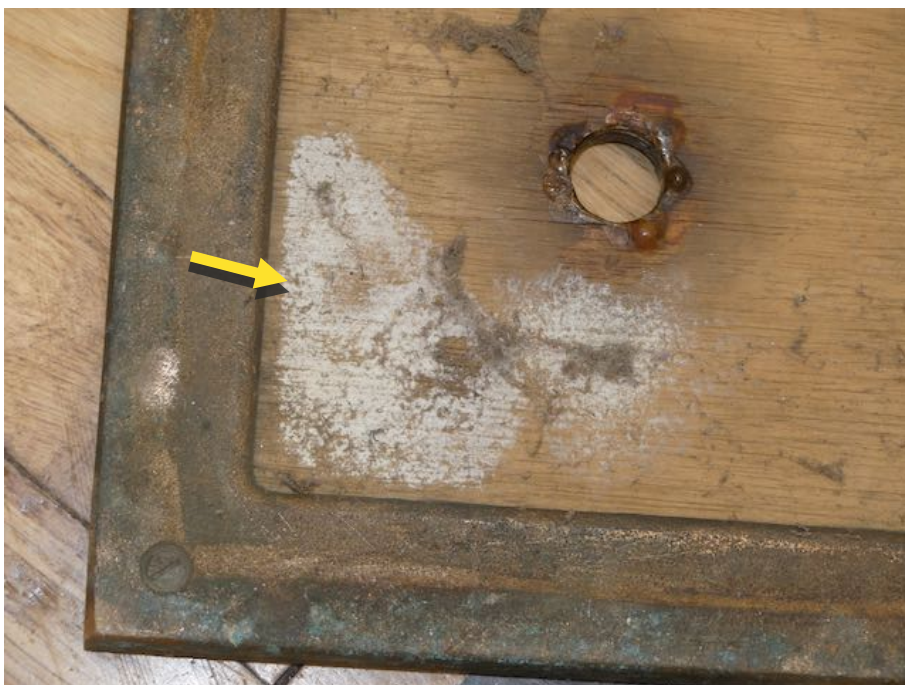
Foto 14: Turnhalle Mitte links, exemplarische Aufnahme geöffneter Deckel, sichtbarer Bewuchs der Holzunterseiten
