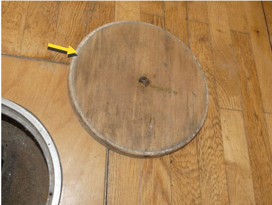
Foto 17: Turnhalle rückwärtiger Bereich, Sichtbarer Schimmelbewuchs an der Unterseite eines Deckels
