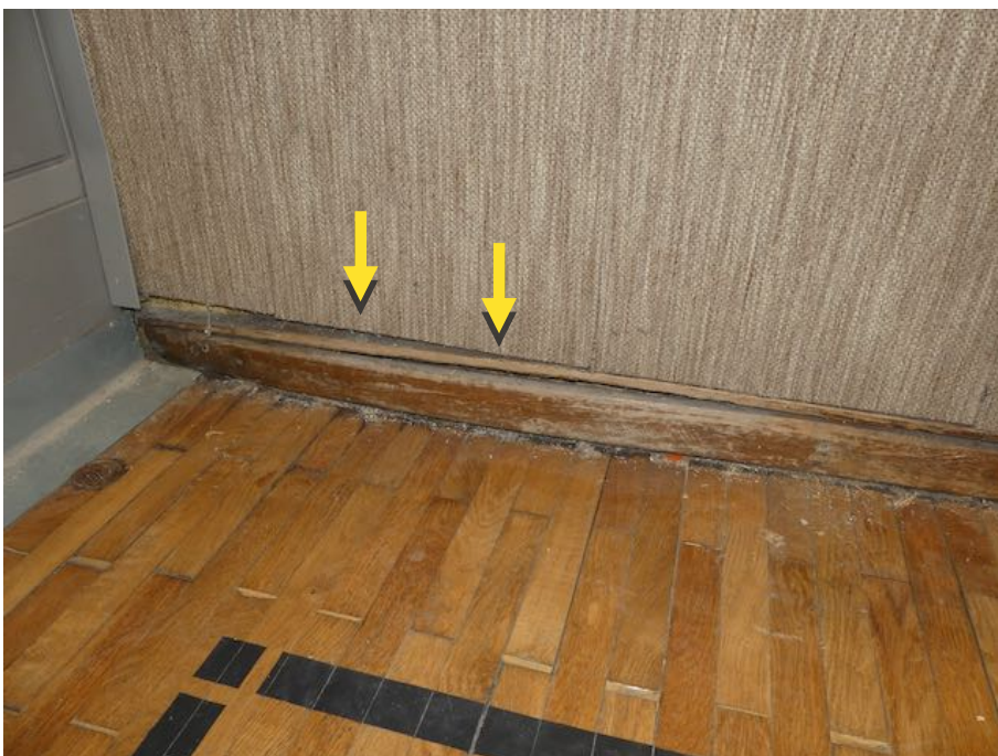
Foto 16: Turnhalle rückwärtiger Bereich, Aufgrund von Feuchtigkeitseinwirkung stark verformte Sockelleiste, nähere Ansicht
