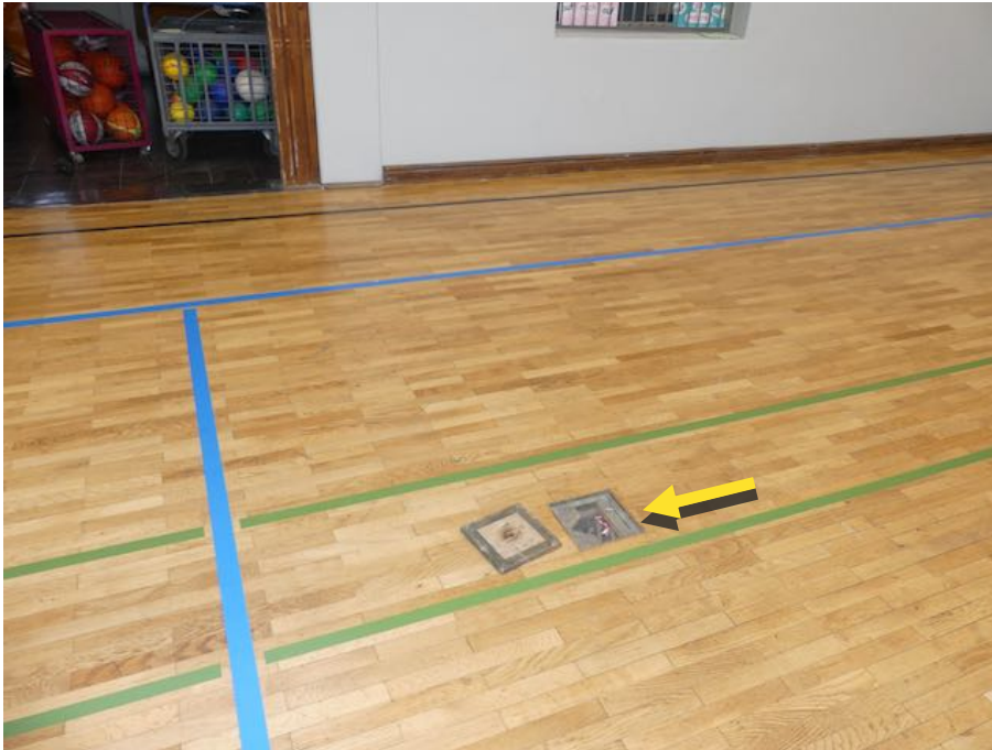
Foto 11: Turnhalle vorne rechts, exemplarische Aufnahme Übersicht Entnahmestelle Probe 80768, sichtbarer Bewuchs der Holzunterseiten
