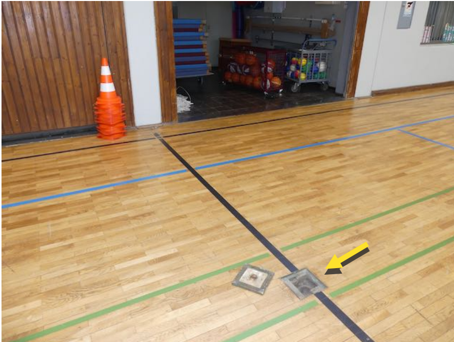
Foto 9: Turnhalle hinterer Teil Mitte, exemplarische Aufnahme, Übersicht Entnahmestelle Probe 80767, sichtbarer Bewuchs der Holzunterseiten
