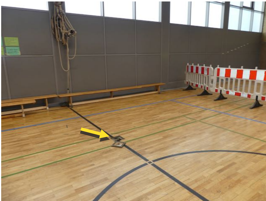
Foto 13: Turnhalle Mitte links, exemplarische Aufnahme Übersicht geöffneter Deckel, sichtbarer Bewuchs der Holzunterseiten
