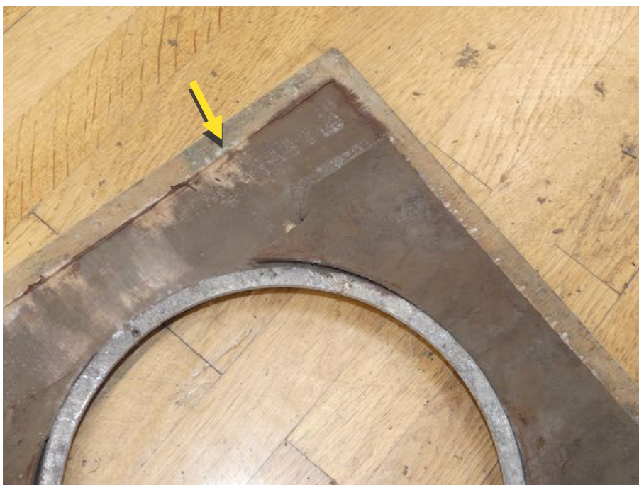
Foto 8: Turnhalle hinterer Teil Mitte, exemplarische Aufnahme, Entnahmestelle Probe 80766, sichtbarer Bewuchs der Holzunterseiten
