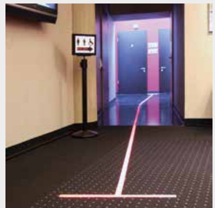
Eine taktiler Leitlinie aus Acrylglas, die mit Hilfe von Leuchtdioden von unten beleuchtet wird, führt zu den Toiletten
