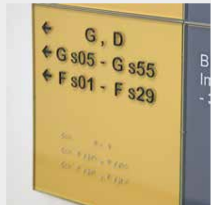
Das kontrastreiche Schild gibt Hinweise auf Gebäudeteile und Raumnummern in erhabener Profilschrift und Brailleschrift
