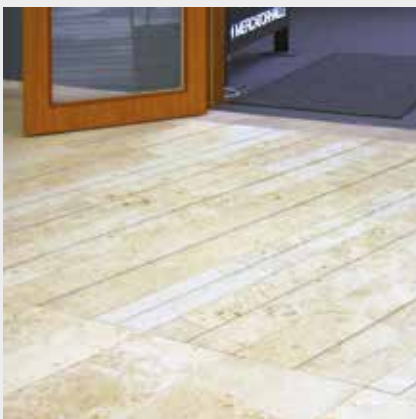
In die Bodenplatten eingefräste Rillen bilden ein taktiler, jedoch nicht kontrastreiches Aufmerksamkeitsfeld vor einem Saaleingang
