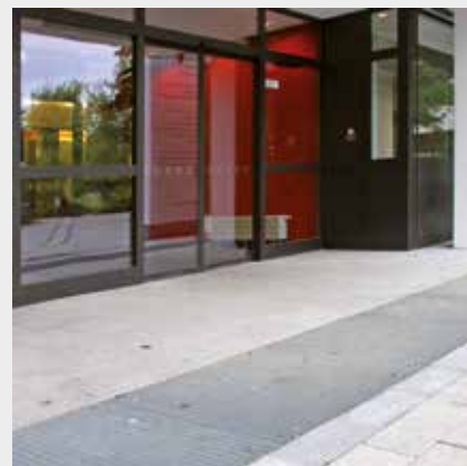
Ein feinmaschiges Drainage-Gitter vor dem Eingang ist auch für Personen im Rollstuhl oder mit Gehbehinderung geeignet
