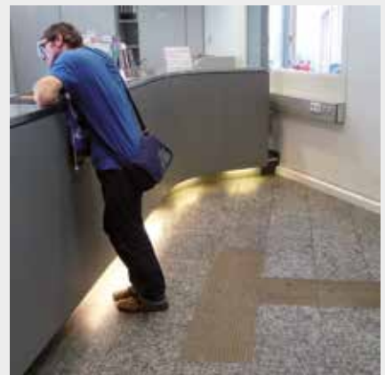
Der taktile, aber nicht ausreichend optisch kontrastreiche Leitstreifen führt zum Empfangstresen
