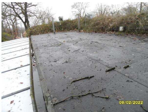
Foto 11: Dach der Stallungen - KMF haltige Dachbahn
