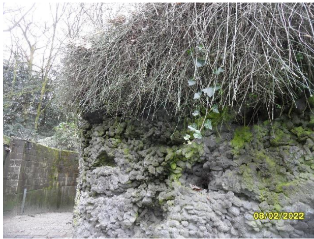
Foto 9: Spritzbetonverkleidung und begrüntes Dach
