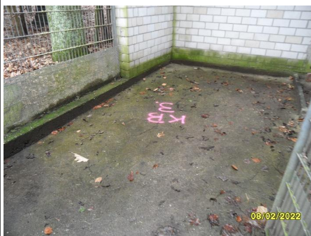
Foto 5: Rückseite Stachelschweingehege - Schleuse mit Stahlbetonboden Kernbohrung 3
