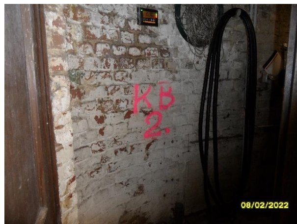
Foto 22: Abstellkammer - unverkleidete Außenwand - Kernbohrung 2
