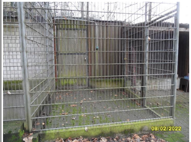
Foto 4: Rückseite Stachelschweingehege - Schleuse mit Stahlbetonboden
