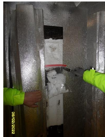
Foto 18: alter Kühlraum Probe: Styropordämmung
