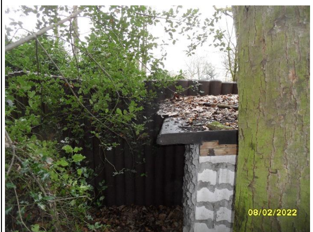
Foto 6: Rückseite Stachelschweingehege - KMF- haltige Dachbahn
