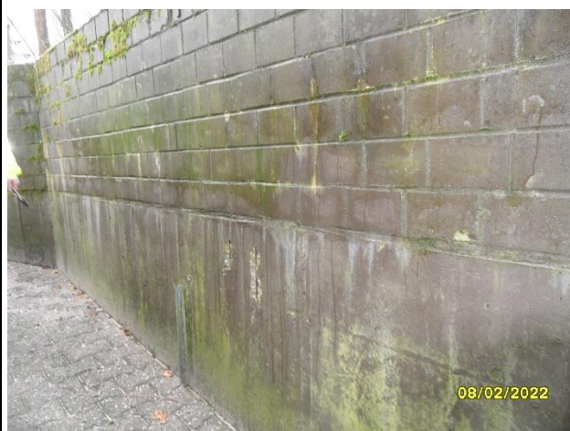
Foto 3: Rückseite Pinguingehege - Mauerwerk auf Stahlbeton
