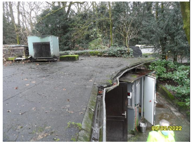
Foto 10: Dach der Stallungen - KMF haltige Dachbahn
