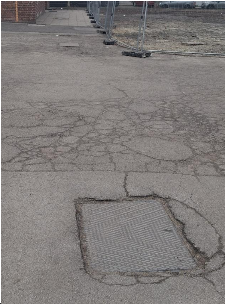
Verlauf des gemauertem Leitungskanals mit den drei auszutauschenden Abdeckungen.
