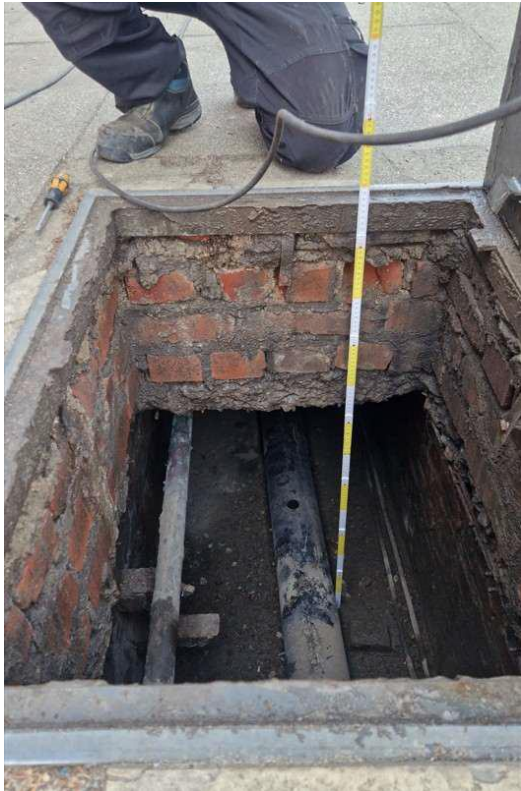
Rechts: Höhe und Aufbau des gemauerten Leitungskanals bei der Untersuchung durch TurboFix vom 03.02.2026
