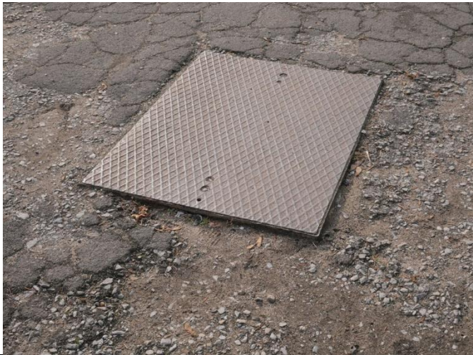
Abdeckung westlich der Zufahrt. PKW-befahrbar.
