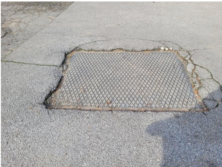
Abdeckung im Zufahrtbereich für Feuerwehr befahrbar. Die neuen Abdeckungen befinden sich im Bereich der neuen Pflasterfläche.
